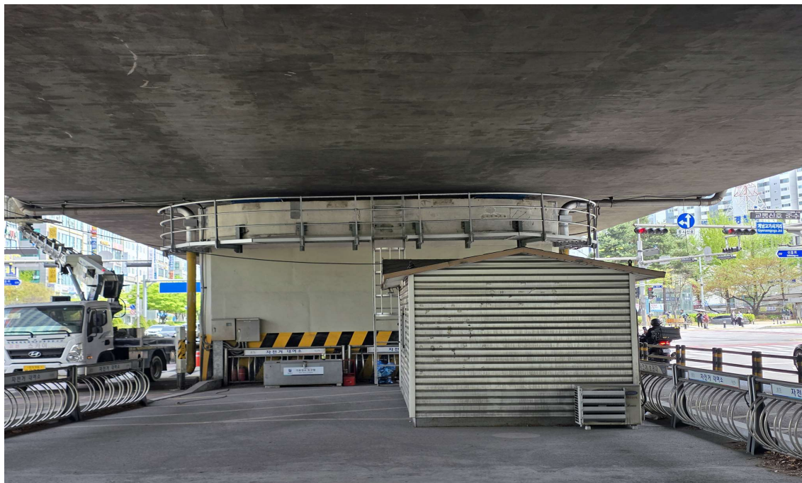
교각 P2 전경
