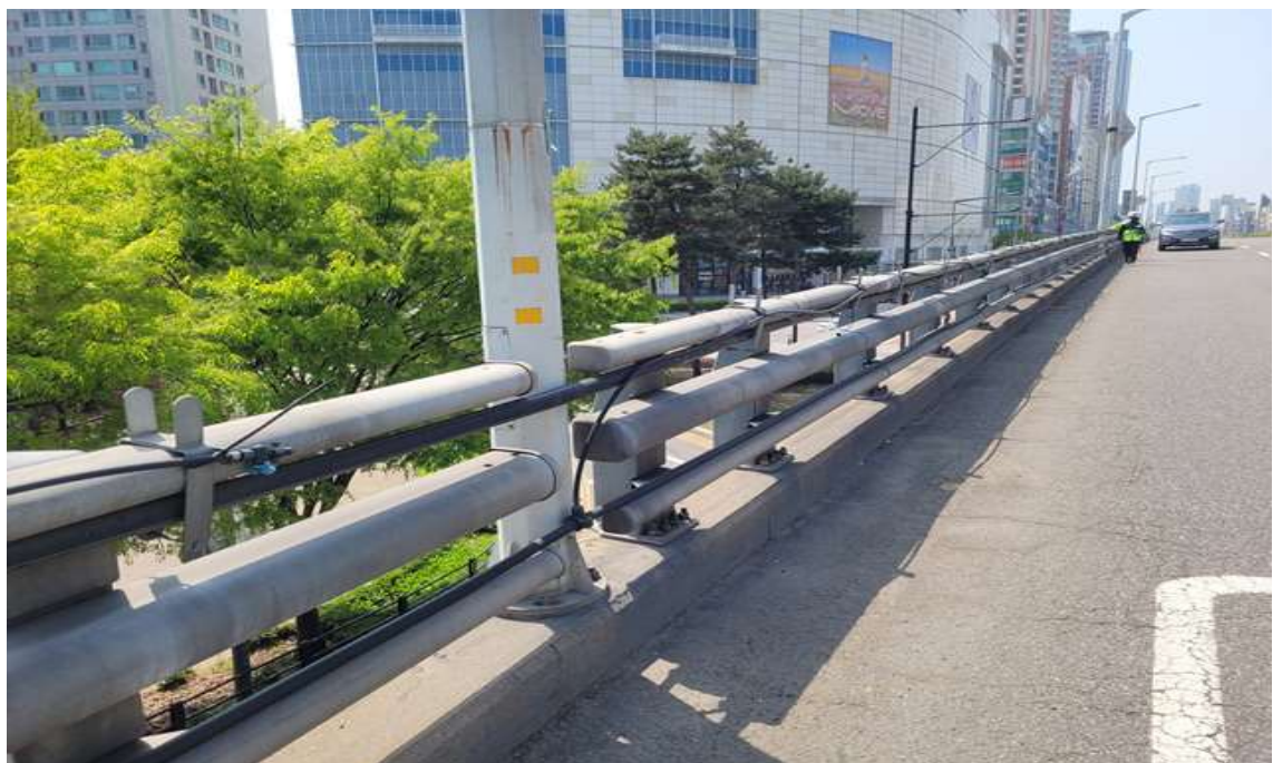
난간 및 연석 전경
