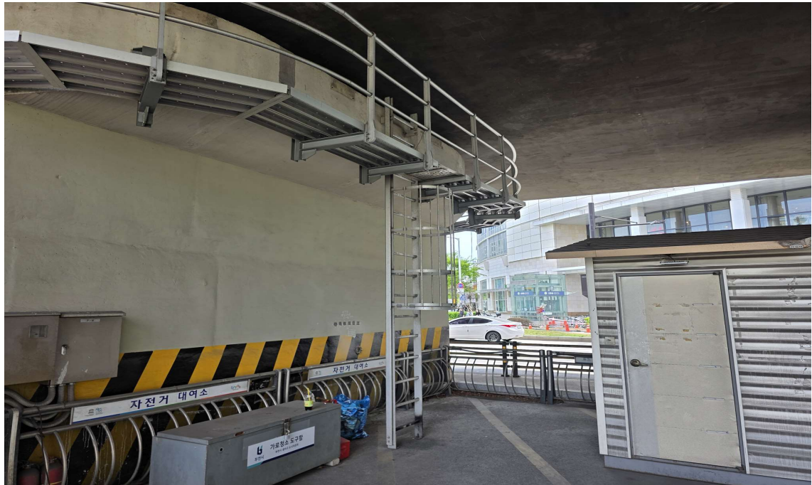
교량 점검시설 전경
